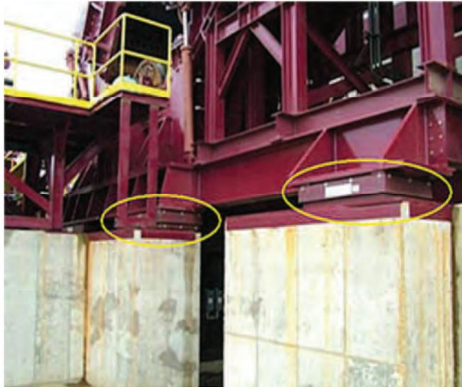
Abbildung 4-5: Isolationselemente zur Erschütterungsminderung<sup>20</sup>
